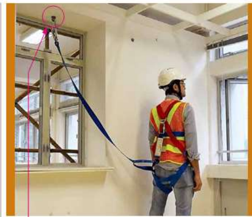
圖 7 - 工人使用有眼螺栓時的情況
